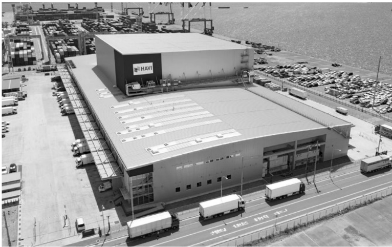
六甲アイランドDC外観
