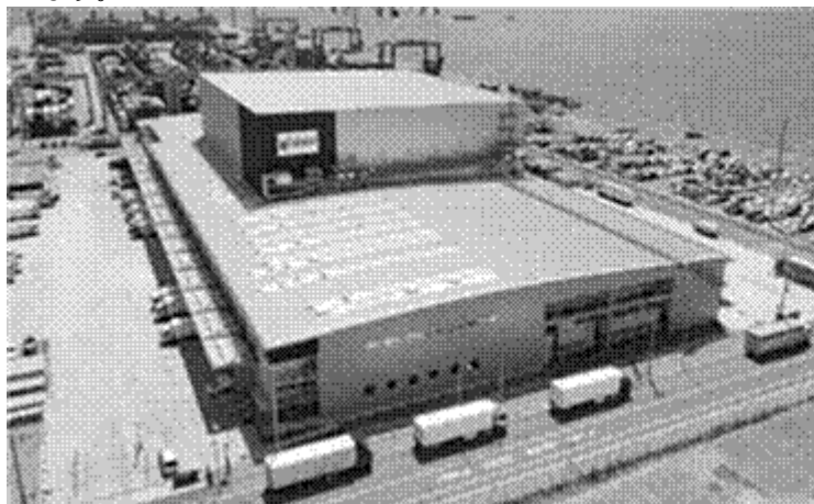
六甲アイランドDC外観
