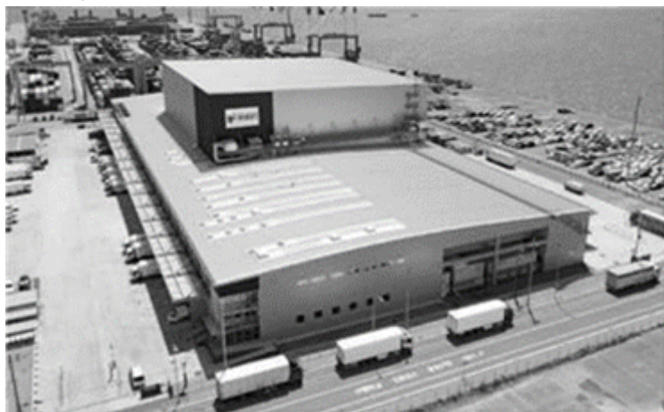
六甲アイランドDC外観
