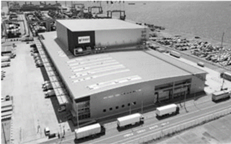
六甲アイランドDC外観
