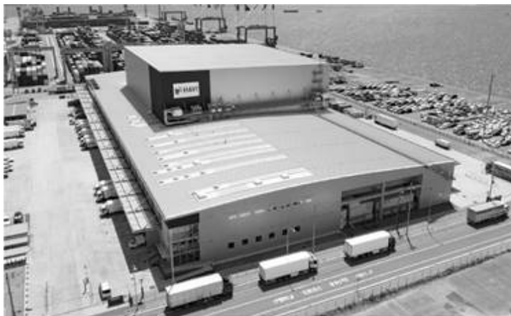
六甲アイランドDC外観
