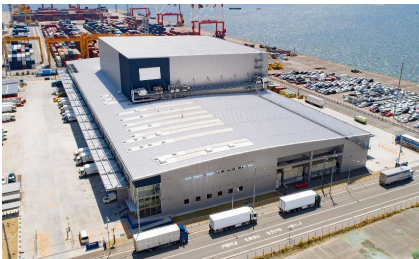
六甲アイランド DC 外観
