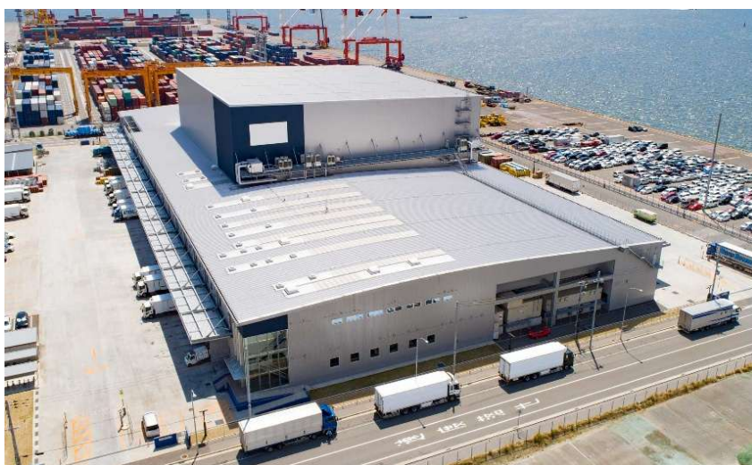
六甲アイランド DC 外観
