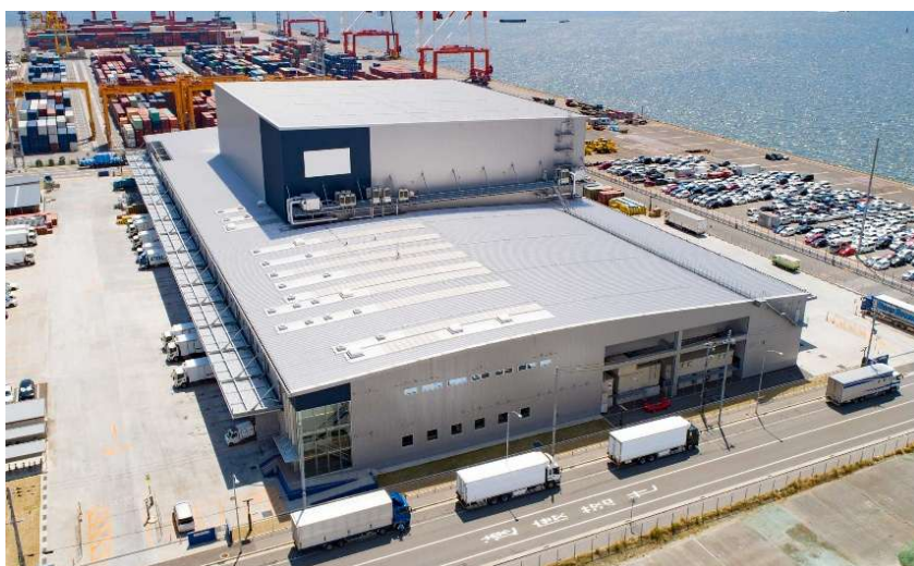
六甲アイランド DC 外観
