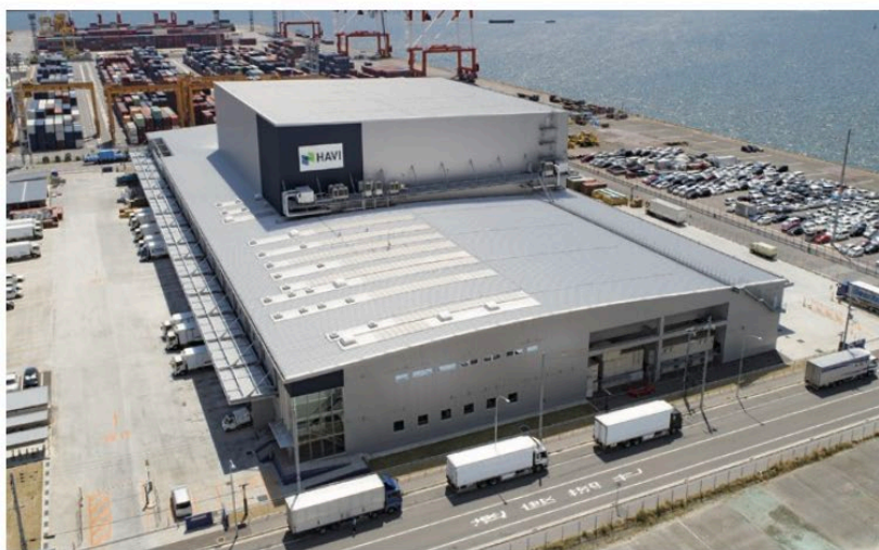
六甲アイランドDC外観
