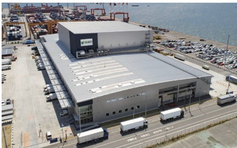
六甲アイランドDC外観
