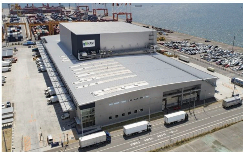
六甲アイランドDC外観
