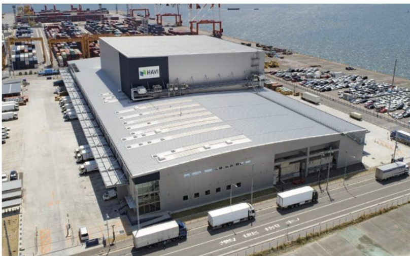
六甲アイランドDC外観
