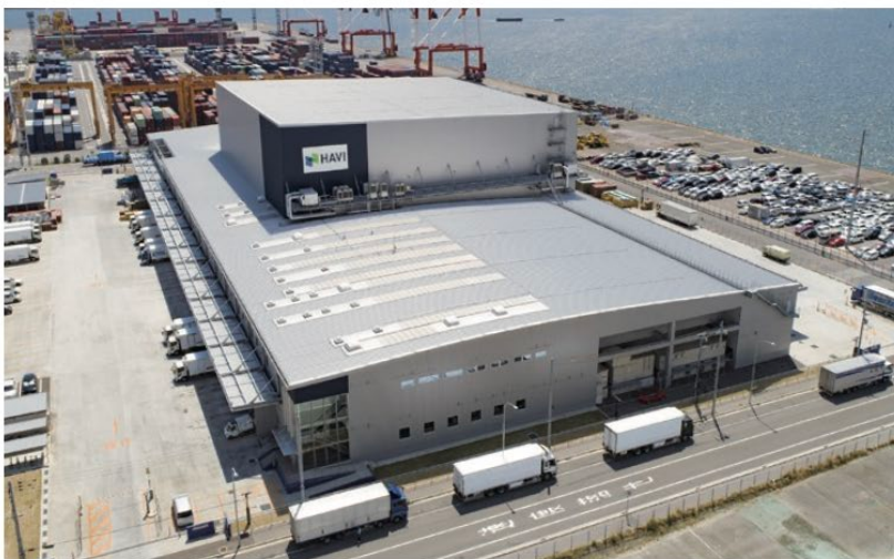
六甲アイランドDC外観
