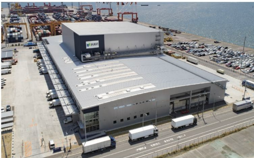
六甲アイランドDC外観
