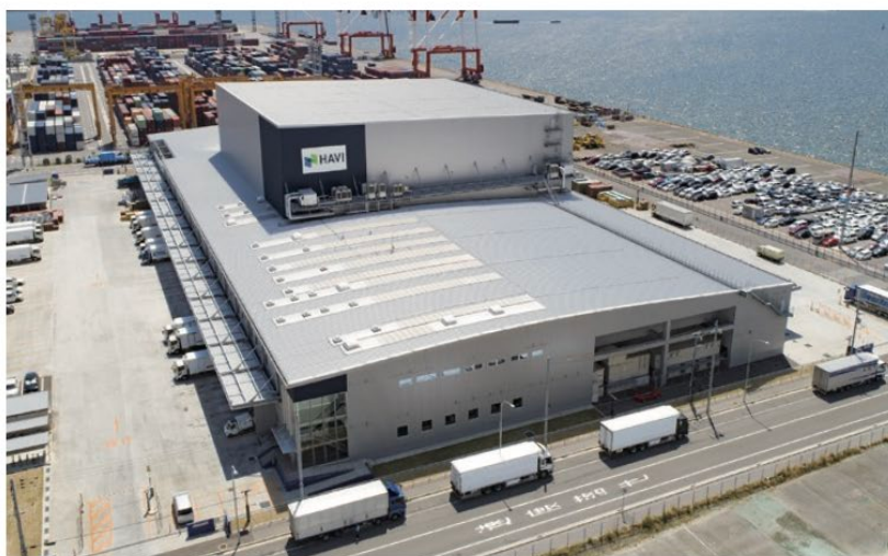
六甲アイランドDC外観
