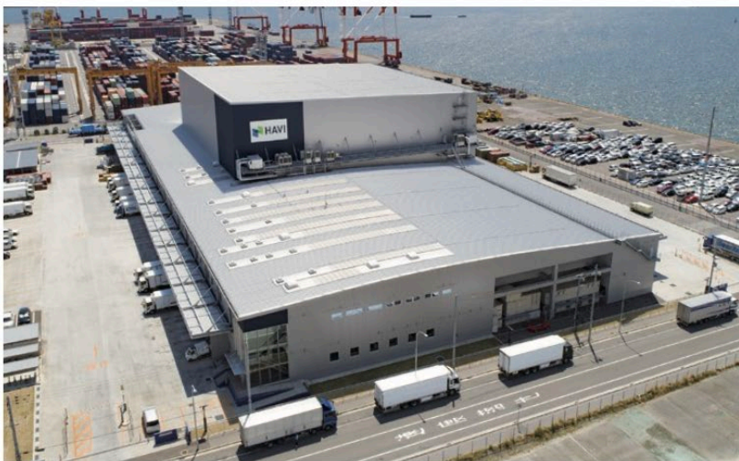
六甲アイランドDC外観
