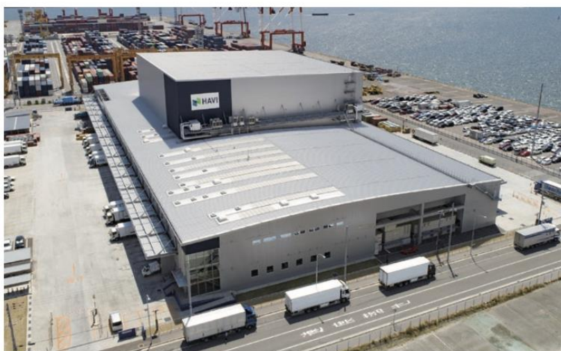
六甲アイランドDC外観
