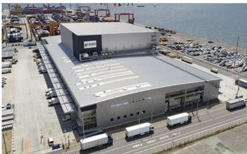
六甲アイランドDC外観
