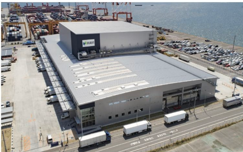
六甲アイランドDC外観
