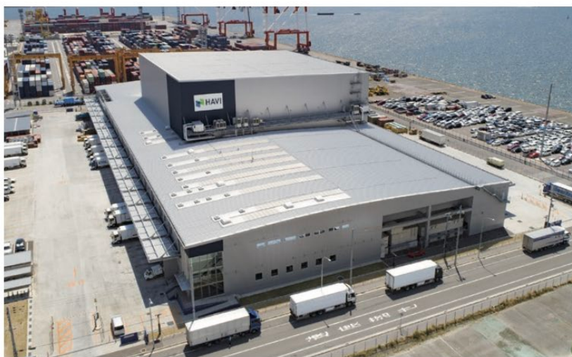
六甲アイランドDC外観
