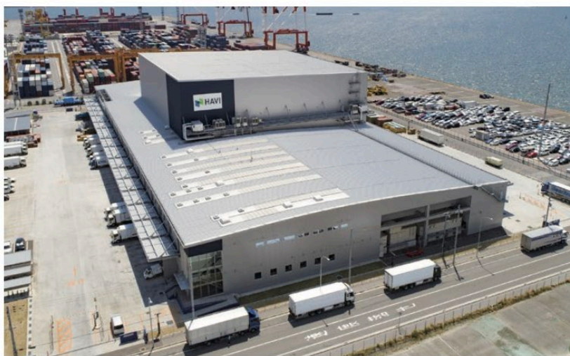
六甲アイランドDC外観
