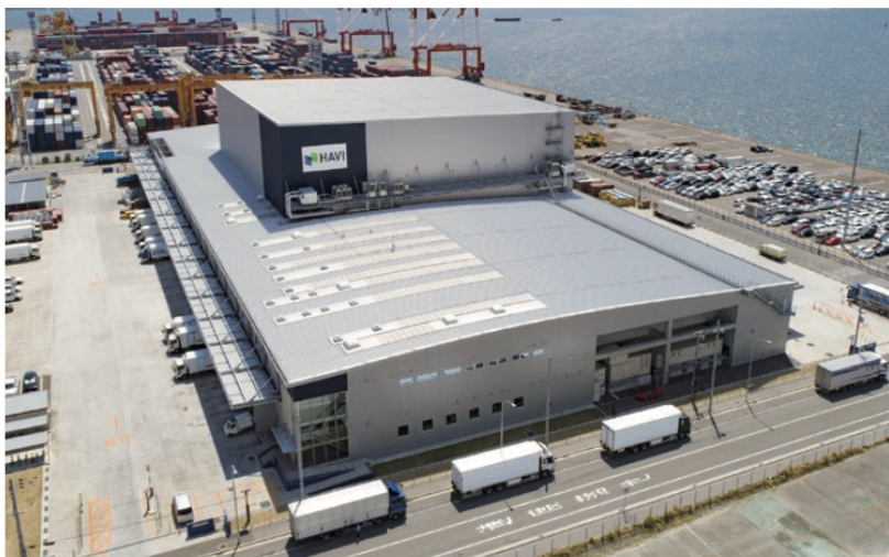
六甲アイランドDC外観
