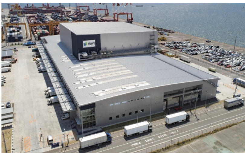
六甲アイランドDC外観
