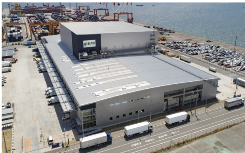
六甲アイランドDC外観
