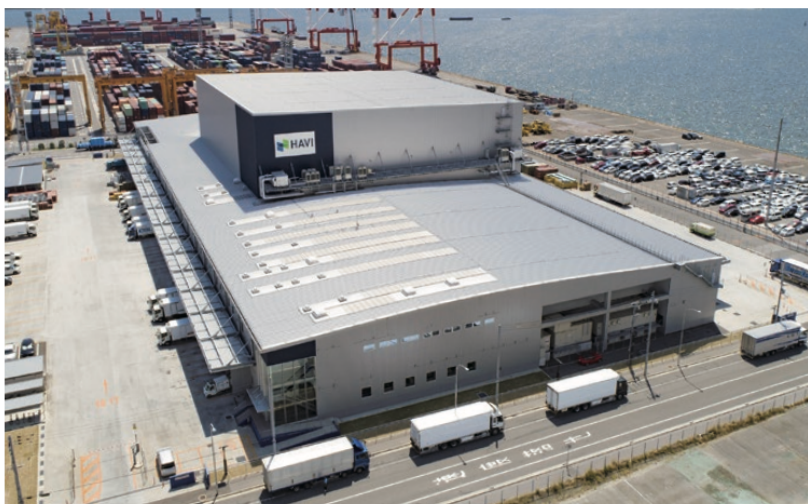
六甲アイランドDC外観
