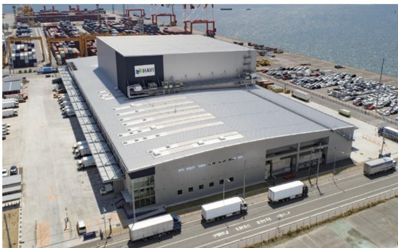
六甲アイランドDC外観
