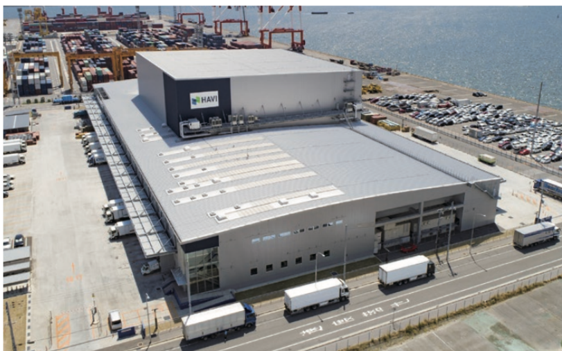
六甲アイランドDC外観
