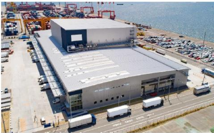
六甲アイランド DC 外観
