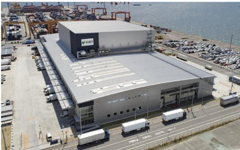
六甲アイランドDC外観
