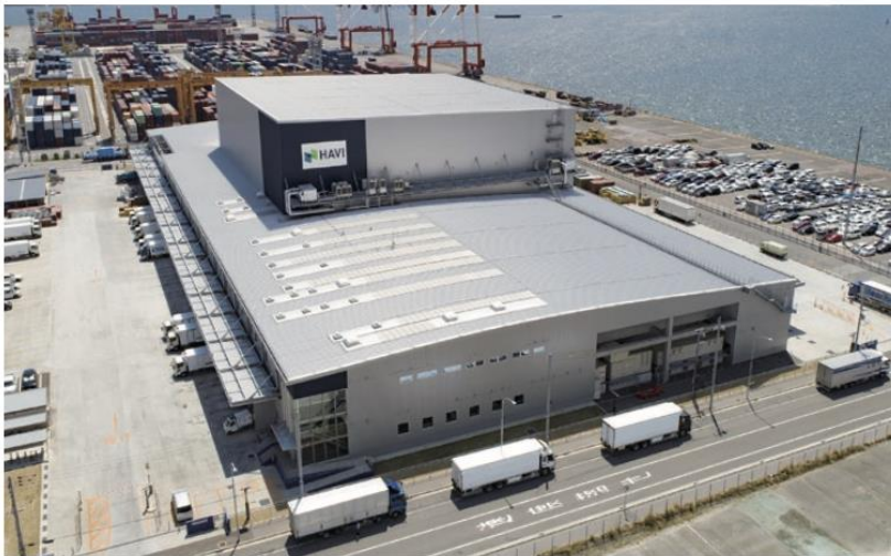
六甲アイランドDC外観
