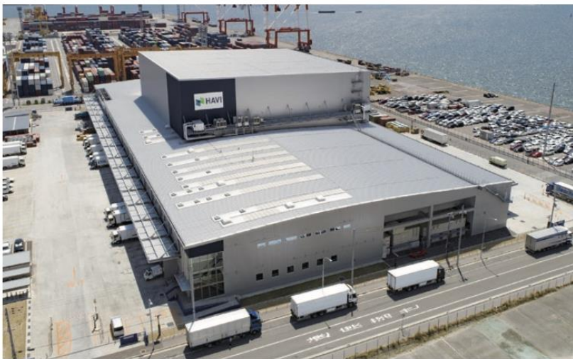
六甲アイランドDC外観
